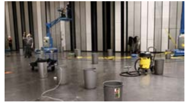
SILFURBERG Slökkviliðsmenn sáu um að hreinsa upp vatnið sem lak inn. FRÉTTABLAÐIÐ/GVA
