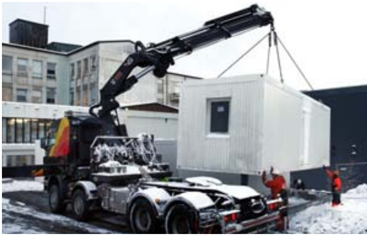
GÁMAR Vinna hófst í gær við að koma gámunum fyrir við húsnæði Landspítalans við Hringbraut og er gert ráð fyrir að henni ljúki innan skamms.
