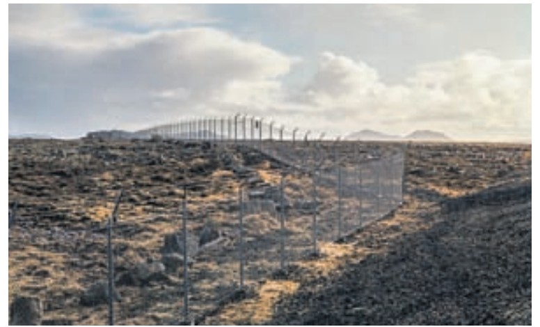
Á HEIÐINNI Svæði varnarliðsins var rammlega girt af og enginn komst þangað öðruvísi en um vaktað hlið–nema fuglinn fljúgandi.
