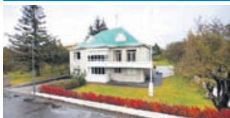
Mánastígur - Hf. - Einstök staðsetning
