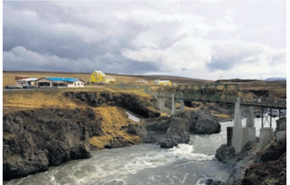
Gamla brúin yfir Skjálfafljót fyrir neðan Goðafoss er 71 m löng stálgrindabrá byggð árið 1930. Brúnni hefur verið haldið við sem göngubrú yfir fljótið.
