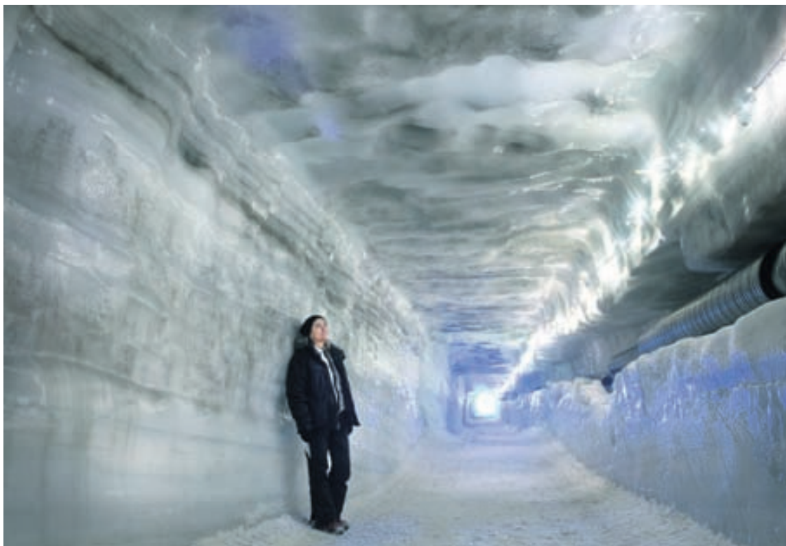
Í JÖKLINUM Þar til led-ljósum hefur verið komið fyrir í ísnum er lýst upp með jólaseríum. Loftræstirör í veggnum víkja og göngin breikka er vinnuvélnar hafa unnið sitt verk. Fjær sést í gangamunnann.
