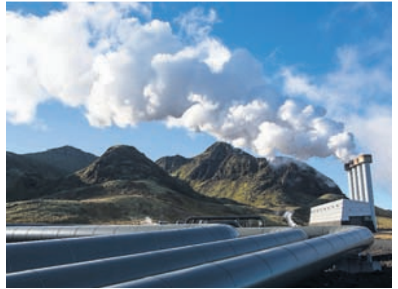
HELLISHEIÐARVIRKJUN Framleiðslugetan er 303 MW en vinnslusvæðið stendur ekki undir uppsettu afli verksmiðjunnar. FRÉTTABLAÐIÐ/VILHELM
