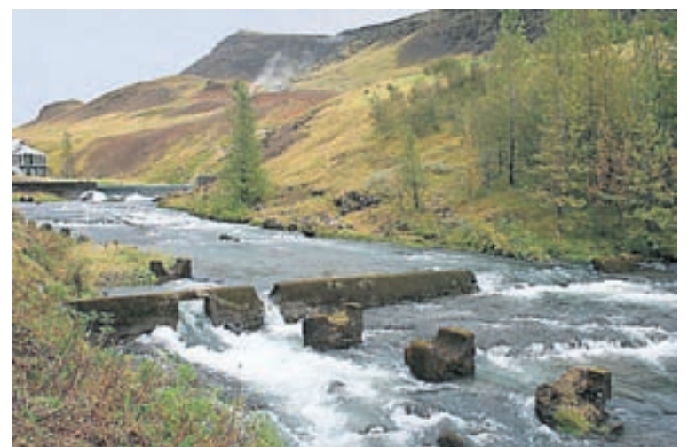
VARMÁ Leifar mannvirkja af aflagðri virkjun sem reist var í Varmá í Ölfusi árið 1929. Stíflumannvirkið efst á myndinni er illfært göngufiski. Eldri mannvirki hafa áhrif löngu eftir að þau eru aflögð. MYND/MAGNÚS JÓHANNESSON.
