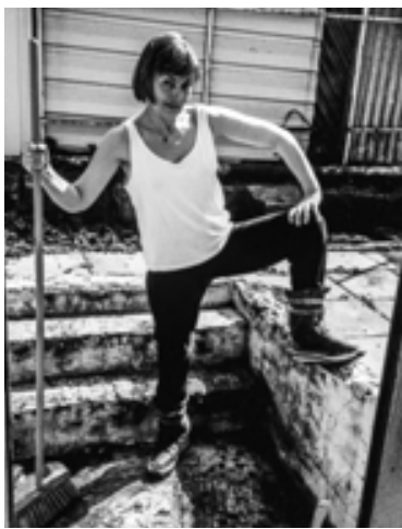
Í FRAMKVÆMDUM Húsið sem hýsir Kramhúsið var mjög illa farið. Hér sést Hafdís á framkvæmdatímanum.
