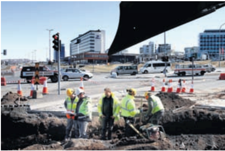
FRAMKVÆMDIR Ný vatnslögn við Kringlumýrarbraut olli umferðartöfum um helgina. FRÉTTABLAÐIÐ/GVA
