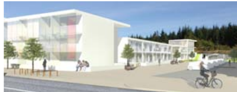
HÁSKÓLAGARÐAR í tilkynningu frá HR segir að bygging Háskólagarðanna sé óháð framtíð Reykjavíkflugvallar í Vatnsmyrinni.
