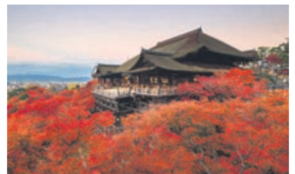
HOF OG HALLIR Í fjallshlíðum kringum Kýótó eru margar fallegar aldagamlar byggingar og skemmtilegar gönguleiðir.
