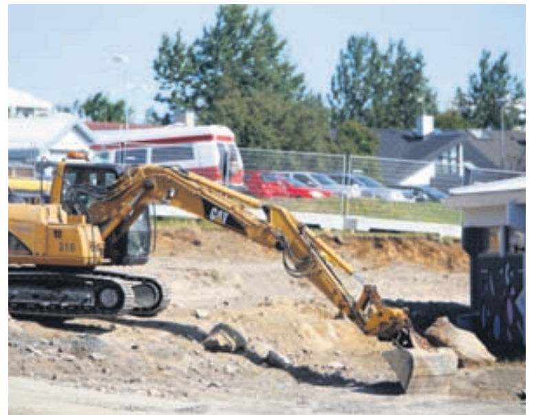
SPRENGINGAR Mikið ónæði er af jarðvegsvinnunni sem nú fer fram við Klettaskóla. Verktakar hafa ekki staðið við umsaminn fjölda sprenginga.
