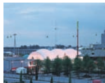
EXPO 2000 Þak japanska skálans á heimssýningunni í Hannover árið 2000 var búið til úr pappír. MYND/HIROYUKI HIRAI
