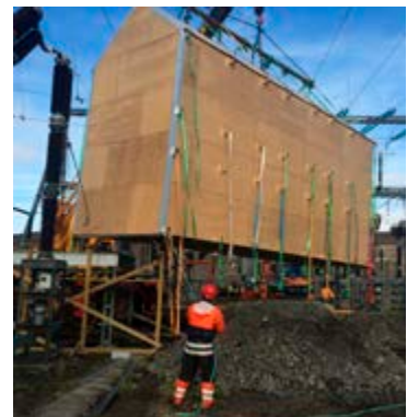
Flutningur á húsi sem tengir vélar 2 og 3 í Sigöldu við tengivirki Landsnets. Mynd/Landsnet
