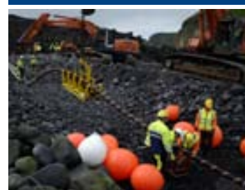
Sæstrengur lagður til Vestmannaeyja. Mynd/Landsnet
