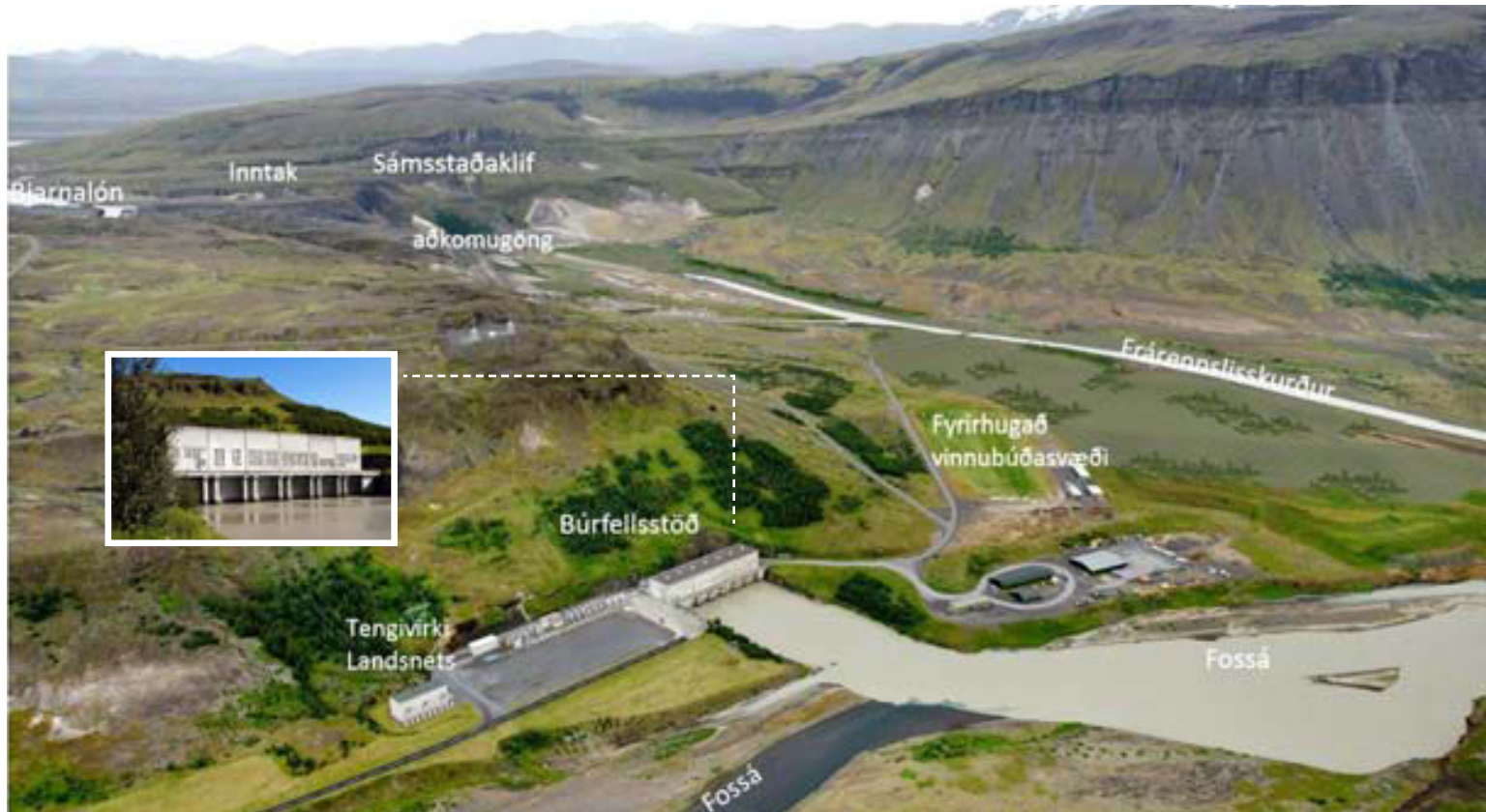
Búrfellsvirkjun var fyrsta stórfamkvæmd Landsvirkjunar og var fyrirtækið stofnað um þá framkvæmd fyrir 50 árum. Helstu umhverfisáhrif nýrrar virkjunar eru aðrennslisskurður, frárennslisskurður og inntaksmannvirki virkjunarinnar. Stöðvarhúsið verður staðsett neðanjarðar í Sámsstaðaklifi. MYND/LANDSVIRKJUN
