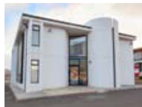
Hátún í Reykjavík 650 m 2 hús Tilbúið til afhendingar.
