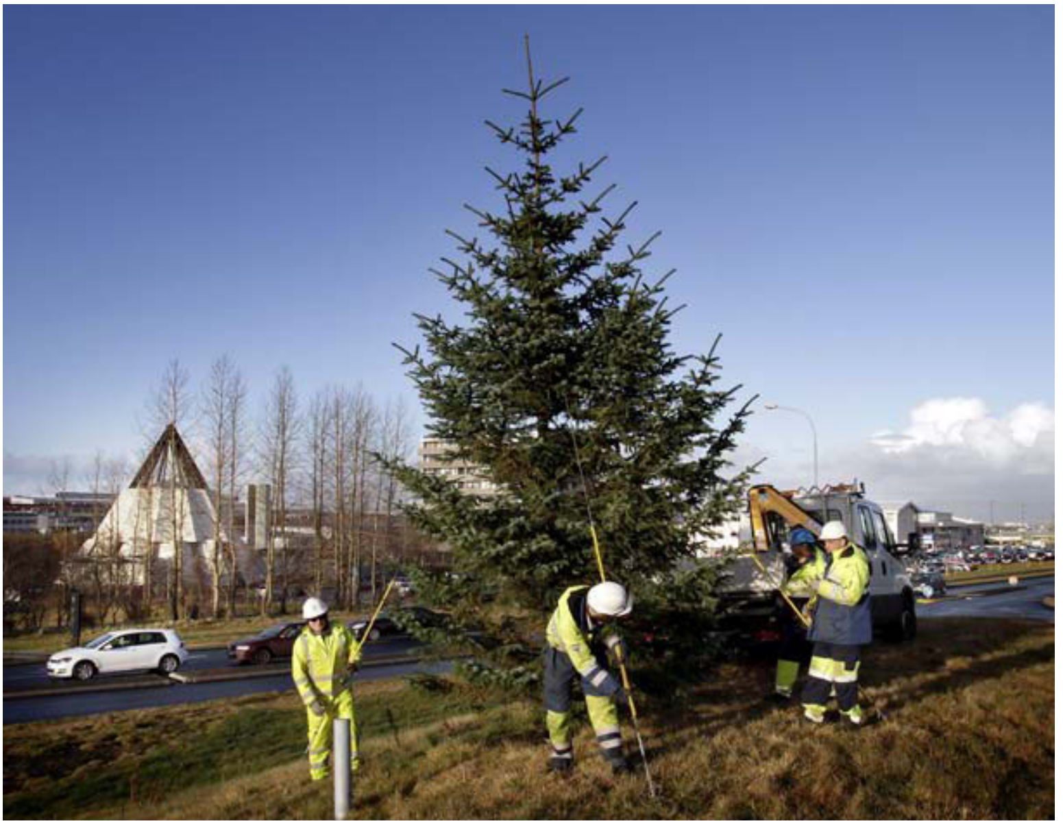
Starfsmenn Reykjavíkurborgar eru þessa dagana að koma fyrir grenitrájum sem höggvin eru í borgarlandinu sjálfu og munu brátt verða skreytt litfögurum jólaseríum. Alls er um að ræða 26 vegleg tré sem gróðursett verða víðsvegar eins og þetta tré sem komið var fyrir við Mjóddina í gær. FRÉTTABLAÐIÐ/GVA
