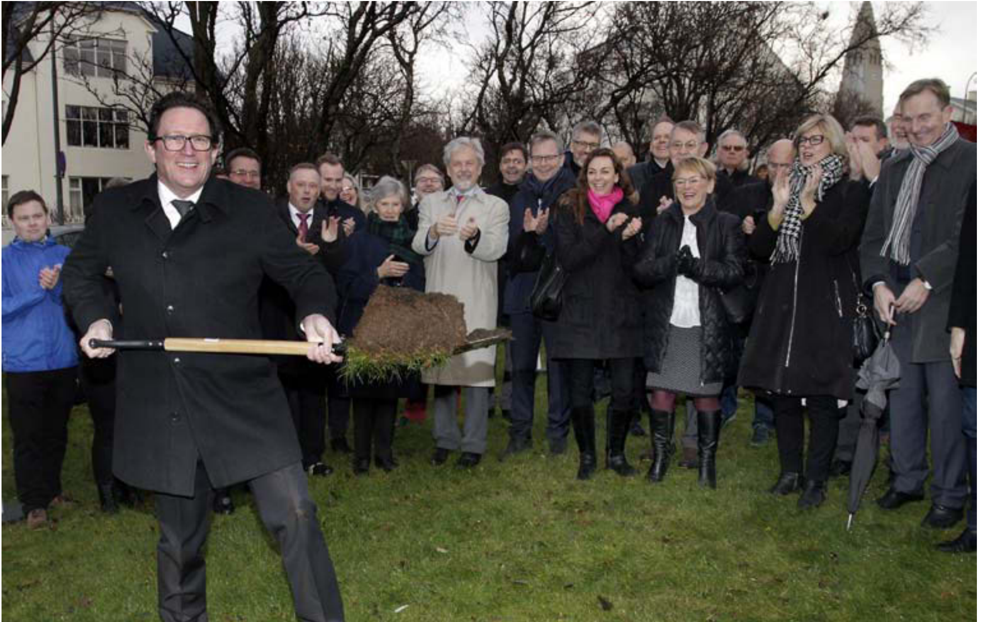
Kristján Þór Júlíusson heilbrigðisráðgjafi tók í gær fyrstu skóflustunguna að byggingu sjúkrahótelis nýs Landspítala og undirritaði verksamning við byggingafyrirtækið sem annast mun framkvæmdina. Á meðal þeirra sem voru viðstaddir voru fyrrverandi heilbrigðisráðgjafar. FRÉTTABLAÐIÐ/GVA
