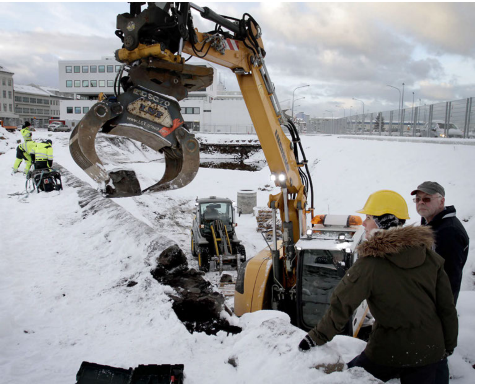
Verið er að rífa gamla hafnargarðinn sem lá undir bílastæðinu við Kolaportið. Hann hefur verið friðaður og mun rísa í sömu mynd í bílakjallara húsanna sem rísa á reitnum. Því þarf að taka garðinn í sundur stein fyrir stein og merkja þá skilmerkilega svo að þeir rati á sinn stað í upphaflegri ásýnd hafnargarðsins. FRÉTTABLAÐIÐ/GVA
