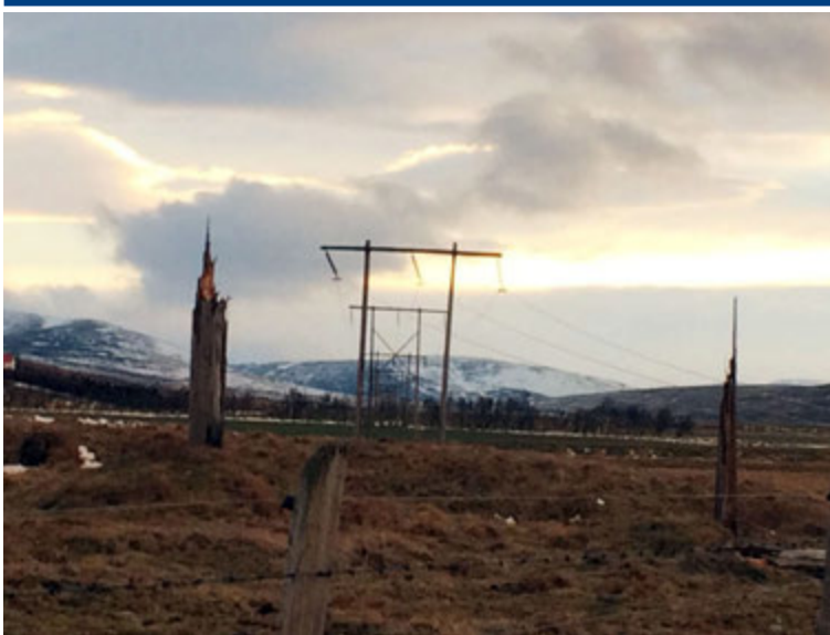
Svona var ástandið við þjóðveginn í Blönduhlíð þar sem möstur í Rangárvallalínu 1 brotnuðu í óveðrinu í byrjun vikunnar. MYND/LANDSNET
