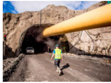
Blásið er heitu lofti inn í göngin til þess að bæta vinnuástandið í göngunum.
