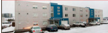
BAUGAKÓR 9 203 KÓPAVOGUR Fjölbýli 2 herb Vel skipulögð íbúð á jarðhæð með stórum, afgirtum palli og staði í bílageymslu í viðhaldslitlu fjölbýli m./lyftu. 73.9 fm 29.900.000 KR. salvor@fr.is 844 1421
