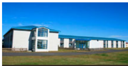
LINDARBRAUT 635 STÆRÐ: 1428 M 2 Byggingin er með 24 einstaklingsíbúðum. Hver íbúð er tæplega 54 fermetrar og samanstendur af stofu, svefnherbergi og baðherbergi.
