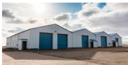
BOGATRÖÐ 1 STÆRÐ: 1500 M 2 Fyrrum viðhaldsverkstæði. Í byggingunni eru klefar og búnaður til bílasprautunar.
