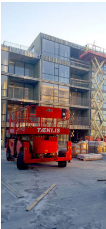
Vélaverkstæði Hjalta Einarssonar við klæðningavinnu við Norðurbakka í Hafnarfirði.
