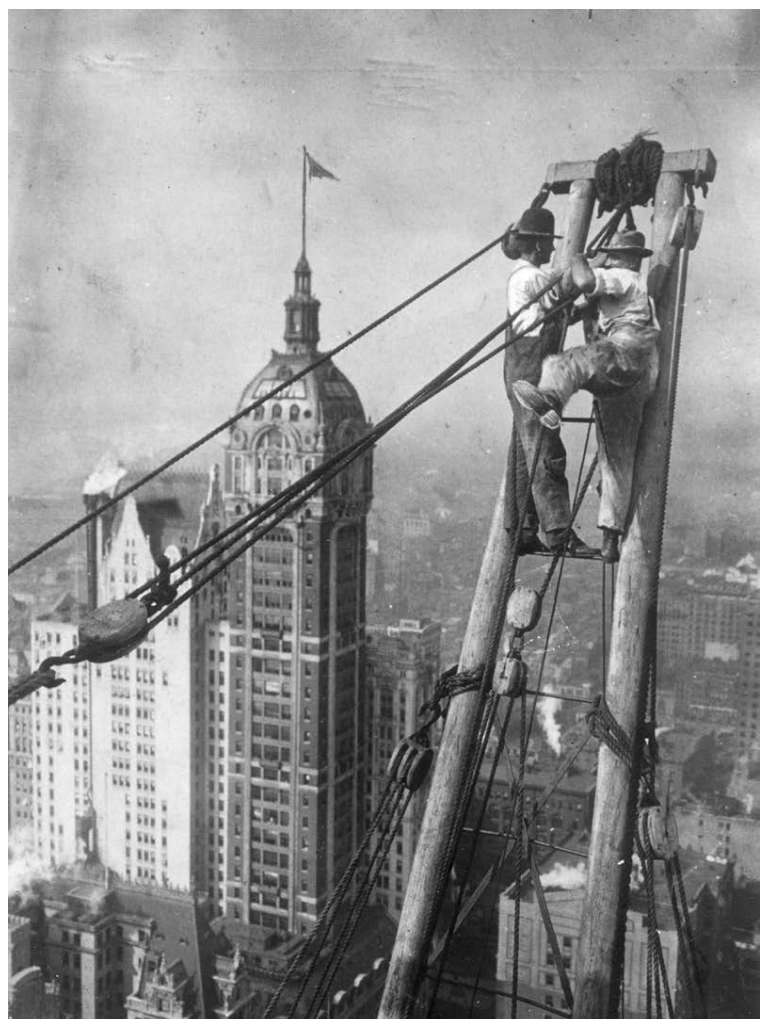
Byggingarverkamenn að störfum hátt yfir húspökum New York-borgar árið 1925. Singer-byggingin sést í bakgrunni. NORDICPHOTOS/GETTY
