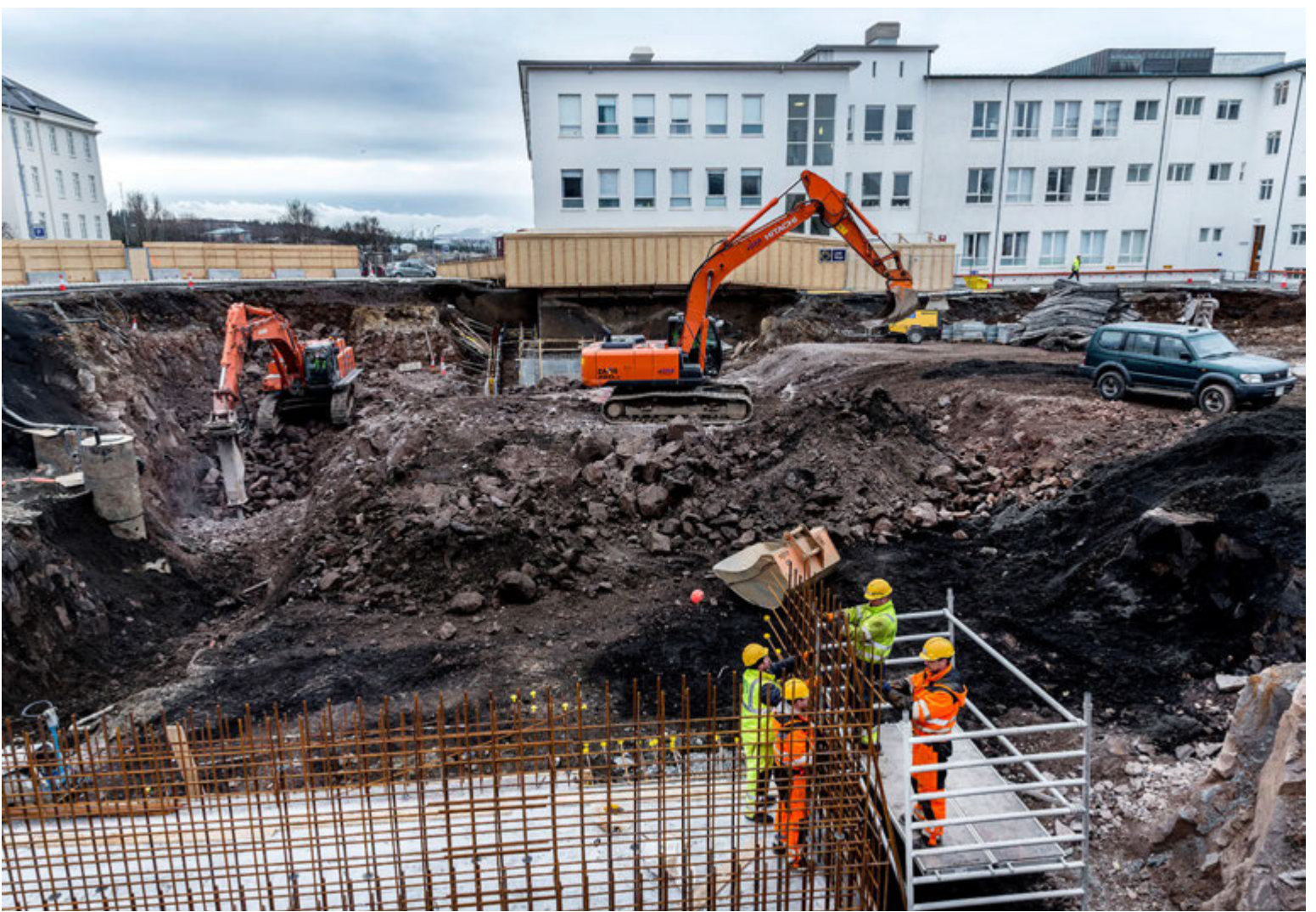
Góður gangur er í byggingu sjúkrahótelins á lóð Landspítalans við Hringbraut. Iðnaðarmenn voru að störfum þegar ljósmyndari Fréttablaðsins átti þar leið um í gær. NLS Saga sér um byggingu nýja sjúkrahótelins sem verður tekið í notkun árið 2017. FRÉTTABLAÐIÐ/VILHELM
