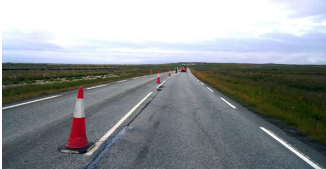
Unnið að sprunguviðgerðum á Vesturlandsvegi.
