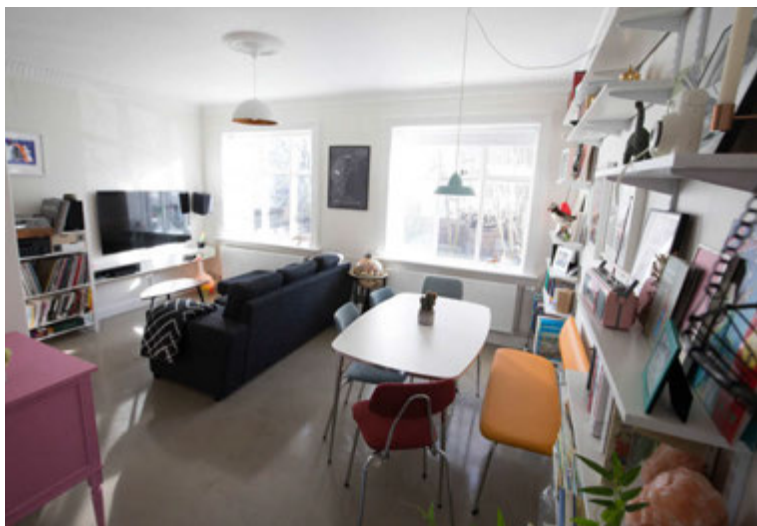
Berglind og Steinþór rifu nánast allt út úr íbúðinni og endurnýjuðu. Öll gólfefni voru tekin upp og gólfíð síðan flotað og lakkað. Borðstofuhúsgögnin fundu þau í Sóló húsgögnum. MYND/BERGLIND
