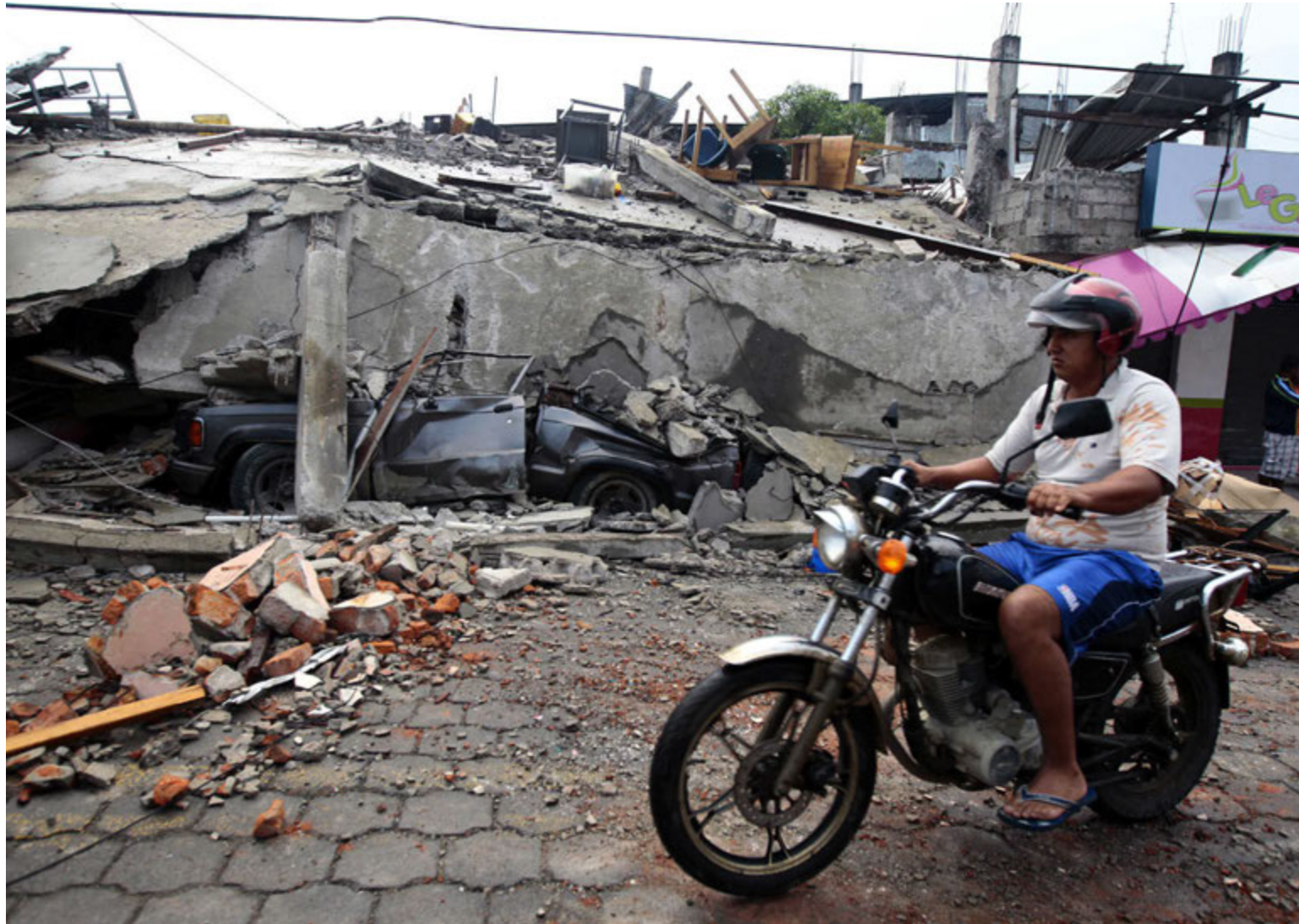
Miklar skemmdir urðu í skjálftanum í Ekvador. Þessi mynd er frá bænum Pedemales þar sem bifreið varð undir þegar bygging hrundi. FRÉTTABLAÐIÐ/EPA
