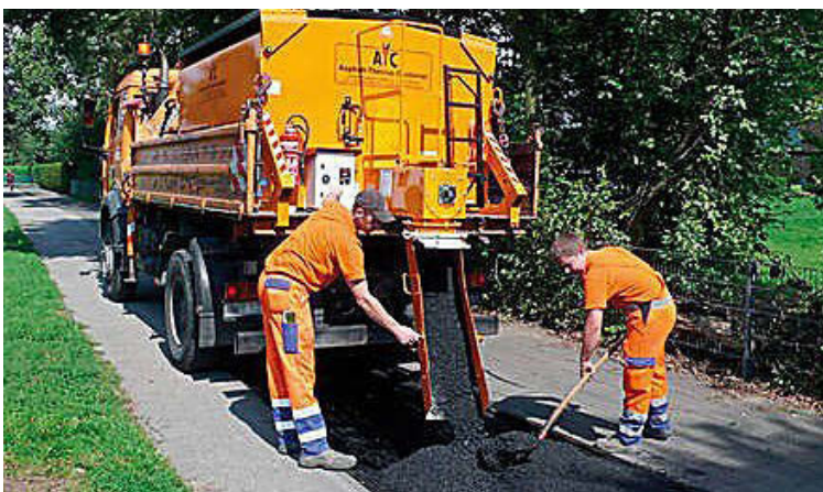
Þegar kemur að vegagerð bjóða Aflvélar ATC malbikskassana frá Þýskalandi sem eru að sögn Friðriks afar hentugir til holufyllinga og viðgerða á malbiki og eru þeir til frá 2,5 tonnum upp í 20 tonn.
