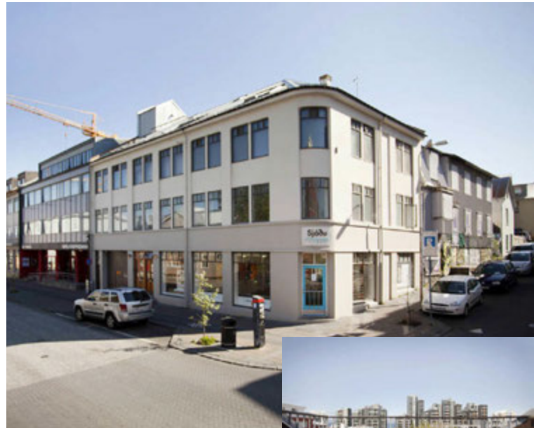
Falleg íbúð á efstu hæð á horni Hverfisgötu og Vatnsstígs.
