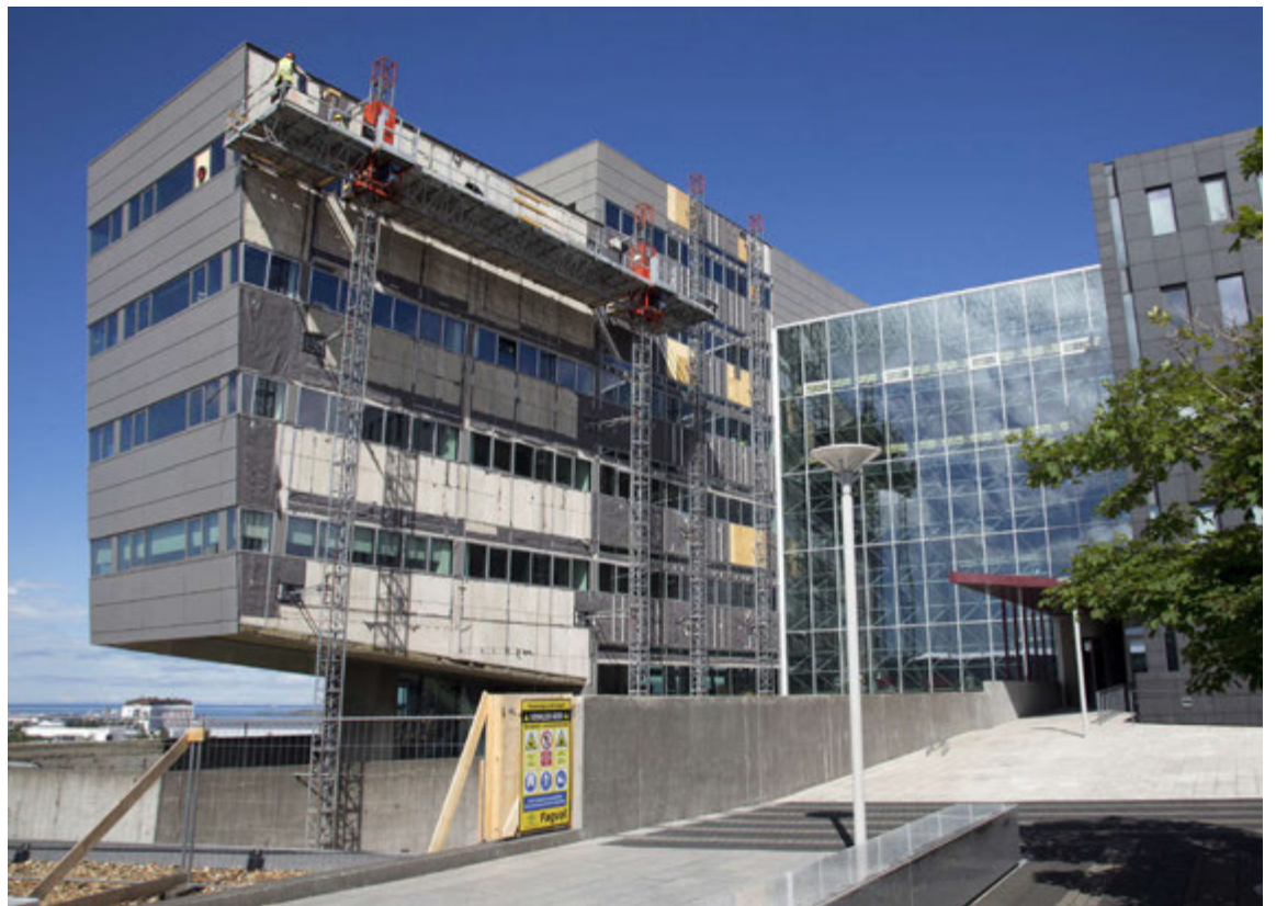
Skoða þarf undir alla klæðningu utanhúss í leit að myglu í miklum viðgerðum á höfuðstöðvum Orkuveitu Reykjavíkur.
