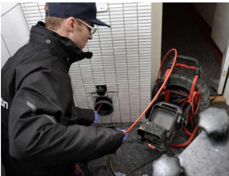
Fyrsta skrefið er að mynda lagnirnar til að kanna ástand þeirra.
