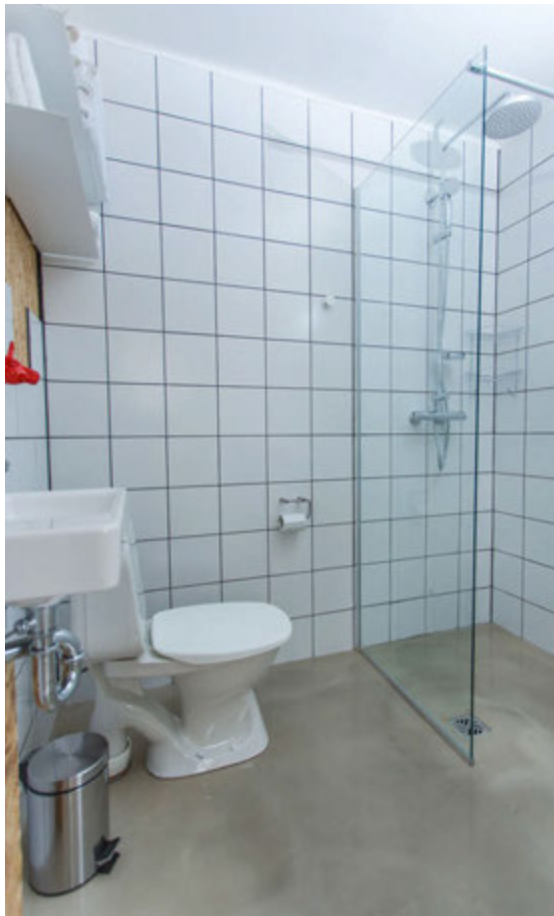
Upprunalegt salerni og vaskur fengu að halda sér, gólfíð var flotað og steypur vatnshalli í sturtuna.
