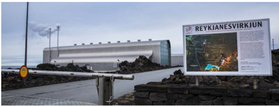
Reykjanesvirkjun er raforkuver sem virkjar jarðvarma. FRÉTTABLAÐIÐ/VILHELM
