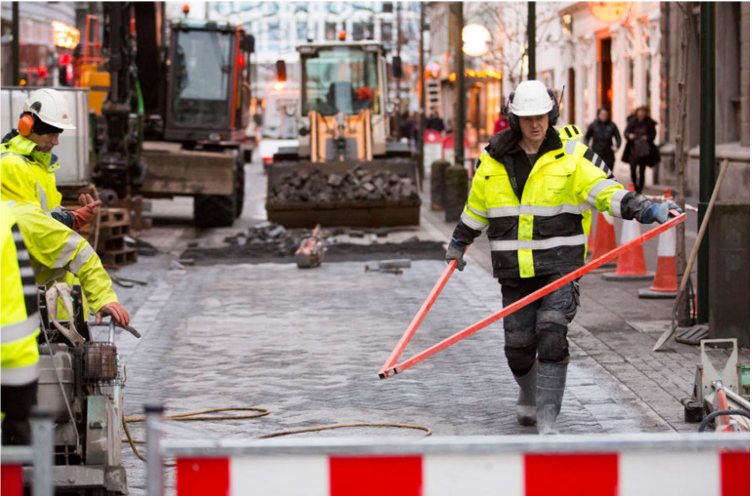
Þessa dagana er unnið að endurbótum og viðhaldi á Austurstræti. Starfsmenn á vegum borgarinnar skipta út eldri hellum í götunni og leggja nýjar auk þess sem undirlagið er jafnað út. Um minniháttar verk er að ræða þótt umsvifin séu nokkur eins og sést á myndinni. Tæpir tveir áratugir eru síðan ráðist var í gagnegar endurbætur á götunni og skipt um allar hellur, hita-, rafmagns-, síma- og snjóbræðslulagnir. FRÉTTABLAÐIÐ/EYÞÓR
