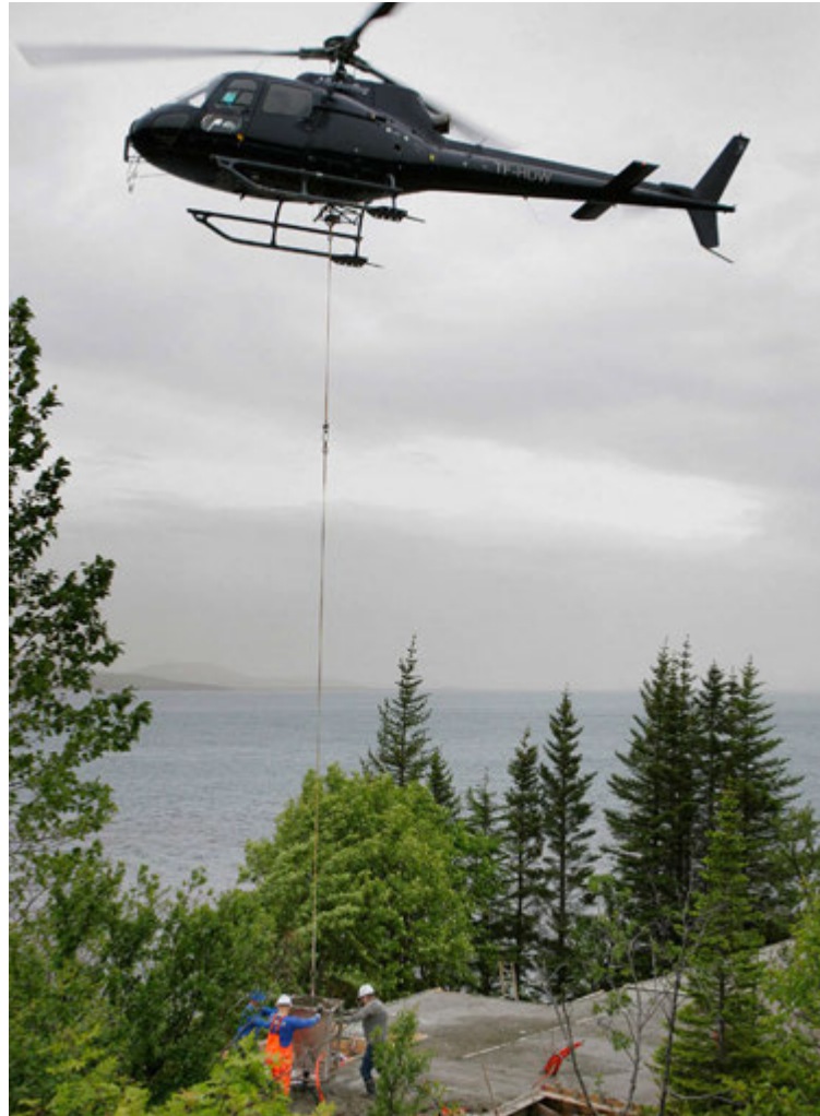
Ekki er víst að steypumassinn sem fluttur var á þessa lóð við Valhallarstíg verði fjarlægður eignist ríkið mannvirkið.
