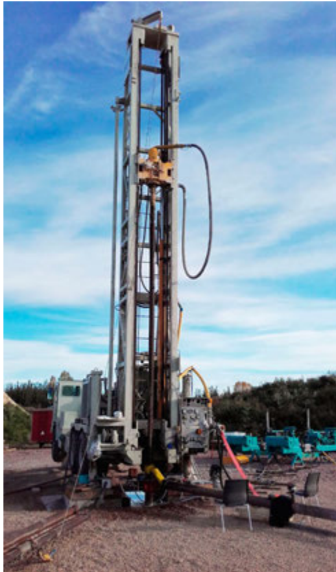
Borun 700 metra gasholu við Siljan-vatnið í Svíþjóð að ljúka.
