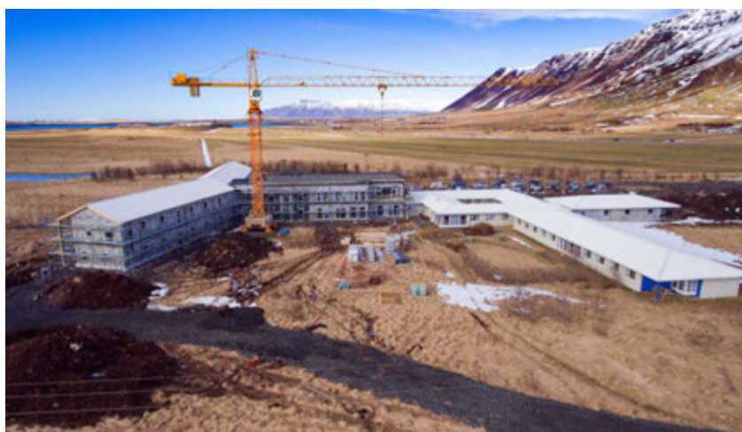
Staða framkvæmdanna við Vík þann 17. mars síðastliðinn, stefnt er að opnun nýju álmunnar í haust. MYND/ÓLAFUR KRISTJÁNSSON
