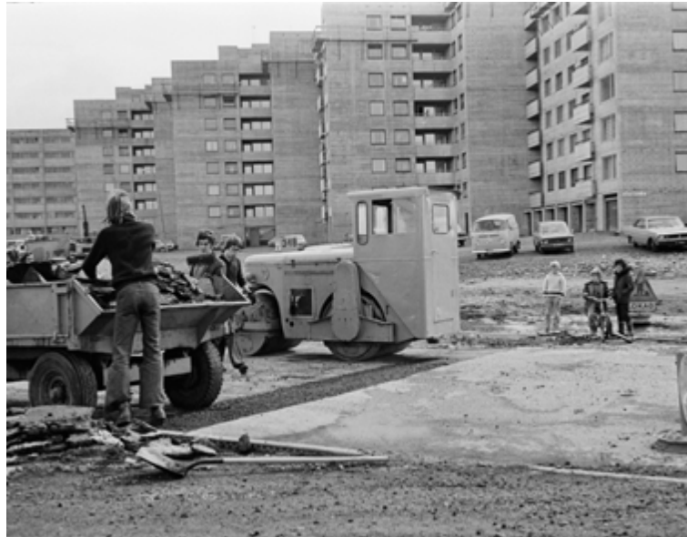
Hér er verið að malbika við Asparfell. Myndin er tekin í maí 1974. Ungir menn hlaða gömlu malbiki á vörubíl. Börn fylgjast með í baksýn.
