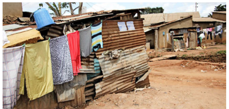
Húsakynni í fátækrahverfunum eru hriplek. Ryðguðu bárujárnir er klambrað saman ofan á og til viðbótar við hálfkörüð og hriplek múrsteinshús.
