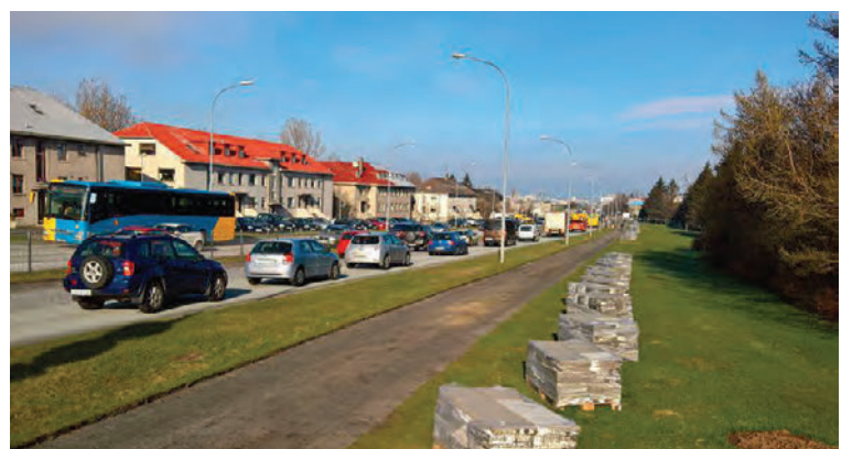
Undirbúningur fyrir framkvæmdirnar. MYND/REYKJAVÍK
