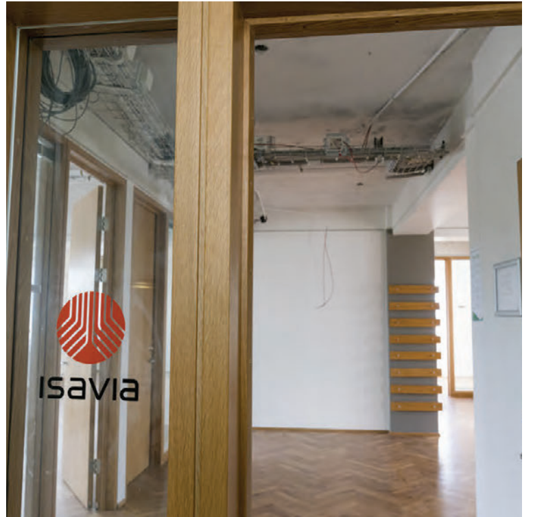
Viðgerðir standa yfir í flugturninum við Reykjavíkflugvöll, en þeim lýkur í haust. Um ár er síðan turninn var rýmdur vegna myglu. FRÉTTABLAÐIÐ/EYÞÓR
