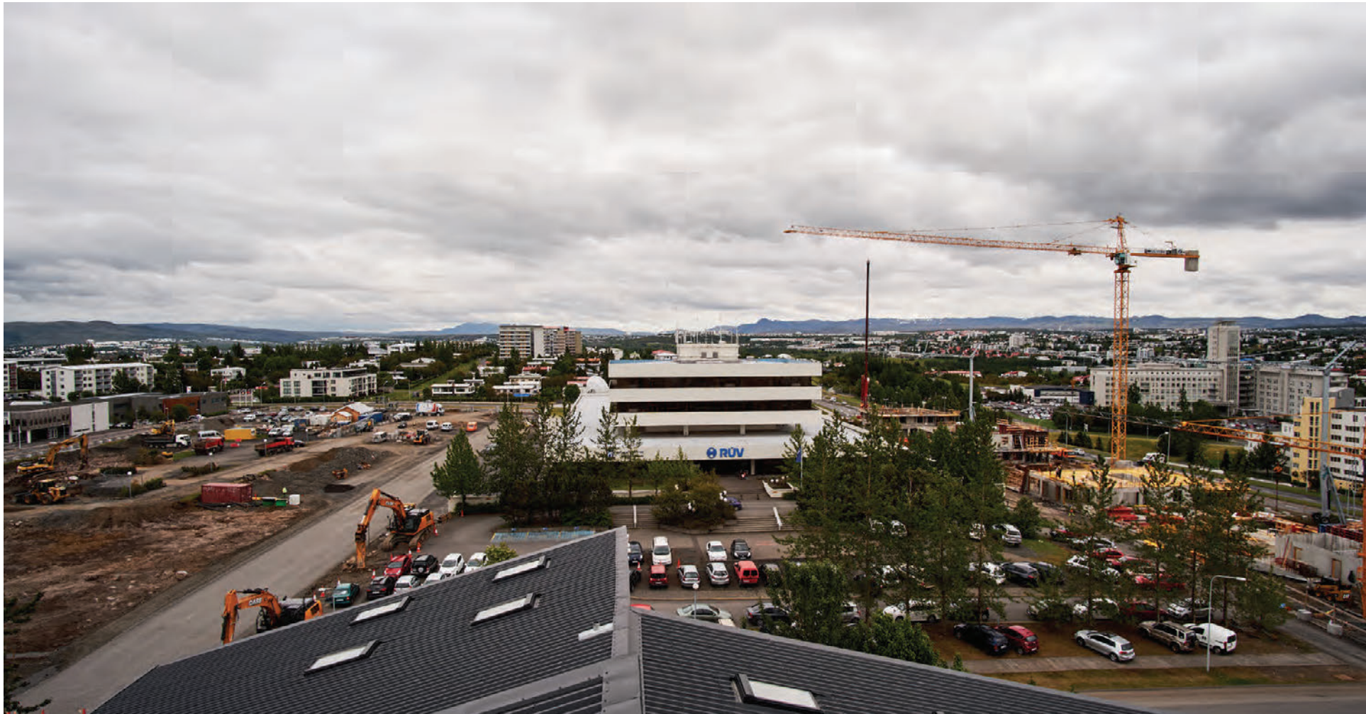
Framkvæmdir á RÚV-reitnum í Efstaleiti í Reykjavík eru í fullum gangi. Um mánaðamótin vísaði úrskurðarnefnd umhverfis- og auðlindamála kæru frá sem miðaði að því að fella breytingar á deiliskipulagi reitsins úr gildi sem og kæru sem miðaði að því að fá byggingarleyfi fyrir Jaðarleiti 2-8 fellt úr gildi. Breytingarnar snéru að aukningu byggingamagns. FRÉTTABLAÐIÐ/ANTON BRINK
