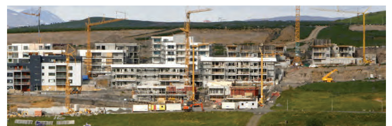
Meðal þess sem var flutt til Færeyja voru byggingakranar og mót. Þegar verkinu lauk var búnaðurinn fluttur aftur til landsins. FRÉTTABLAÐIÐ/ANDRI MARINÓ
