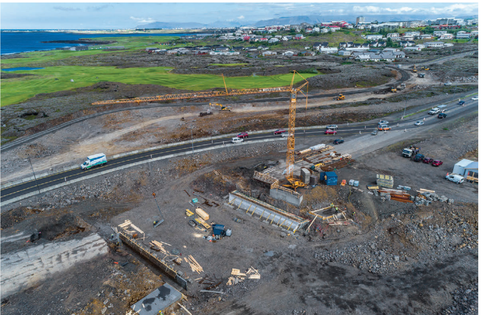
Framkvæmdir eru í gangi við Reykjanesbraut í Hafnarfirði. Er þar verið að gera ný mislæg gatnamót Reykjanesbrautar og Krýsuvíkurvegar. Framkvæmdirnar eru fyrsti áfangi í því að ljúka tvöföldun Reykjanesbrautar, en Jón Gunnarsson samgönguráðherra sagði í upphafi ráðherratiðar sinnar að framkvæmdirnar væru forgangsmál. Gatnamótin eru ein þau hættulegustu á landinu að sögn ráðherrans. FRÉTTABLAÐIÐ/VILHELM
