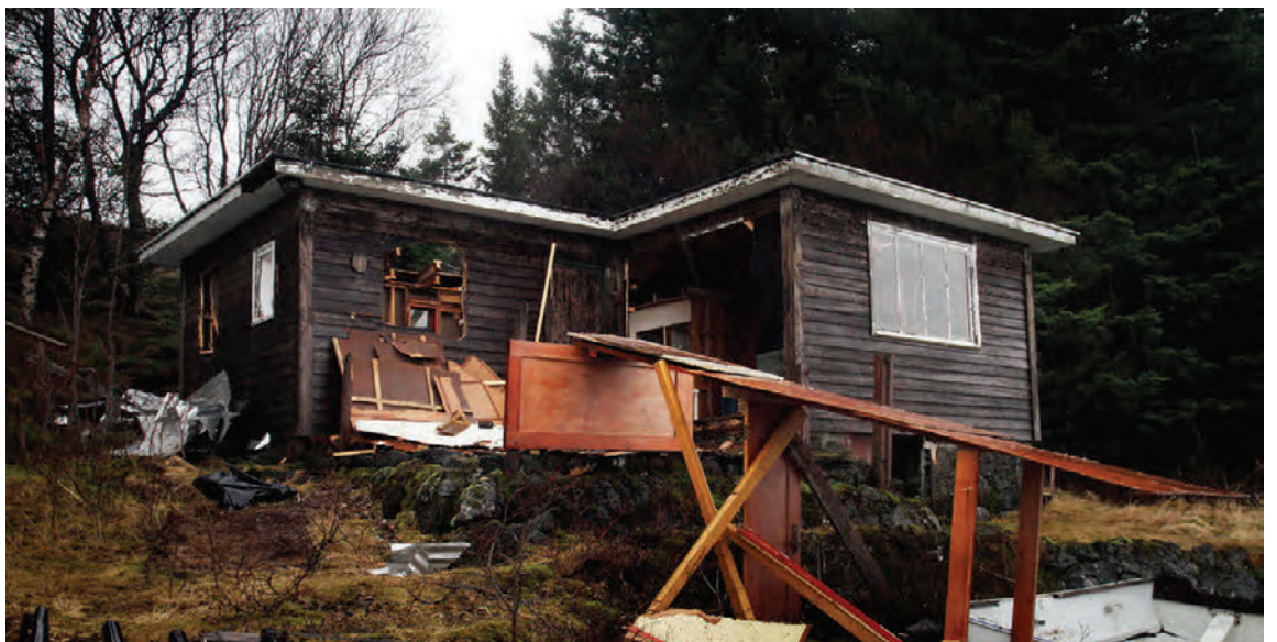
Ónýtt 54 fermetra sumarhús frá 1965 við Þingvallavatn sem ríkið keypti 2014 var rífið í febrúar. FRÉTTABLAÐIÐ/GARÐAR
