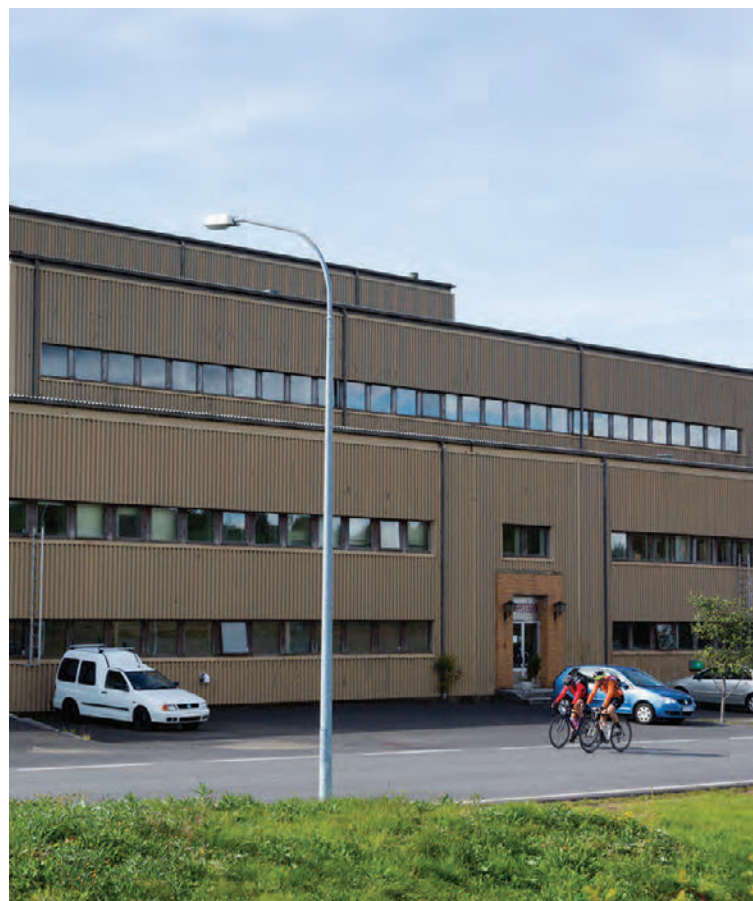
Toppstöðin við Rafstöðvarveg 4 var reist árið 1946. Á sínum tíma stóð til að rífa húsið en þeim áætlunum hefur nú verið breytt. FRÉTTABLAÐIÐ/EYÞÓR
