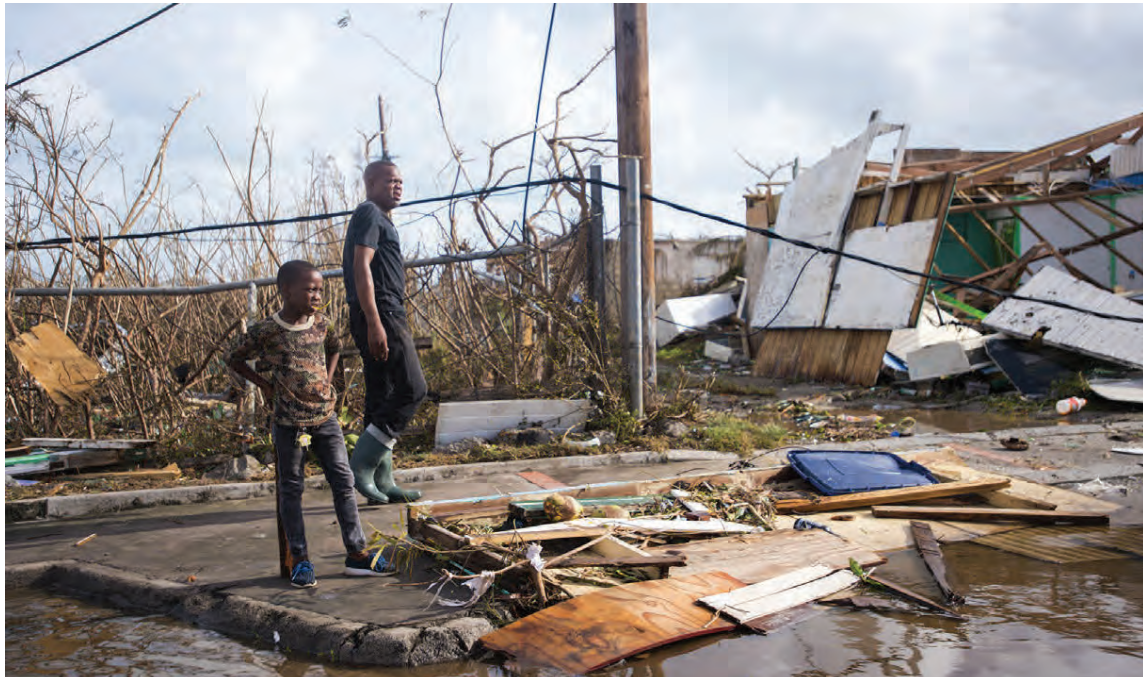
Eyjarskeggjar á Saint-Martin virtu í gær fyrir sér rústirnar sem Irma skildi eftir. NORDICPHOTOS/AFP
