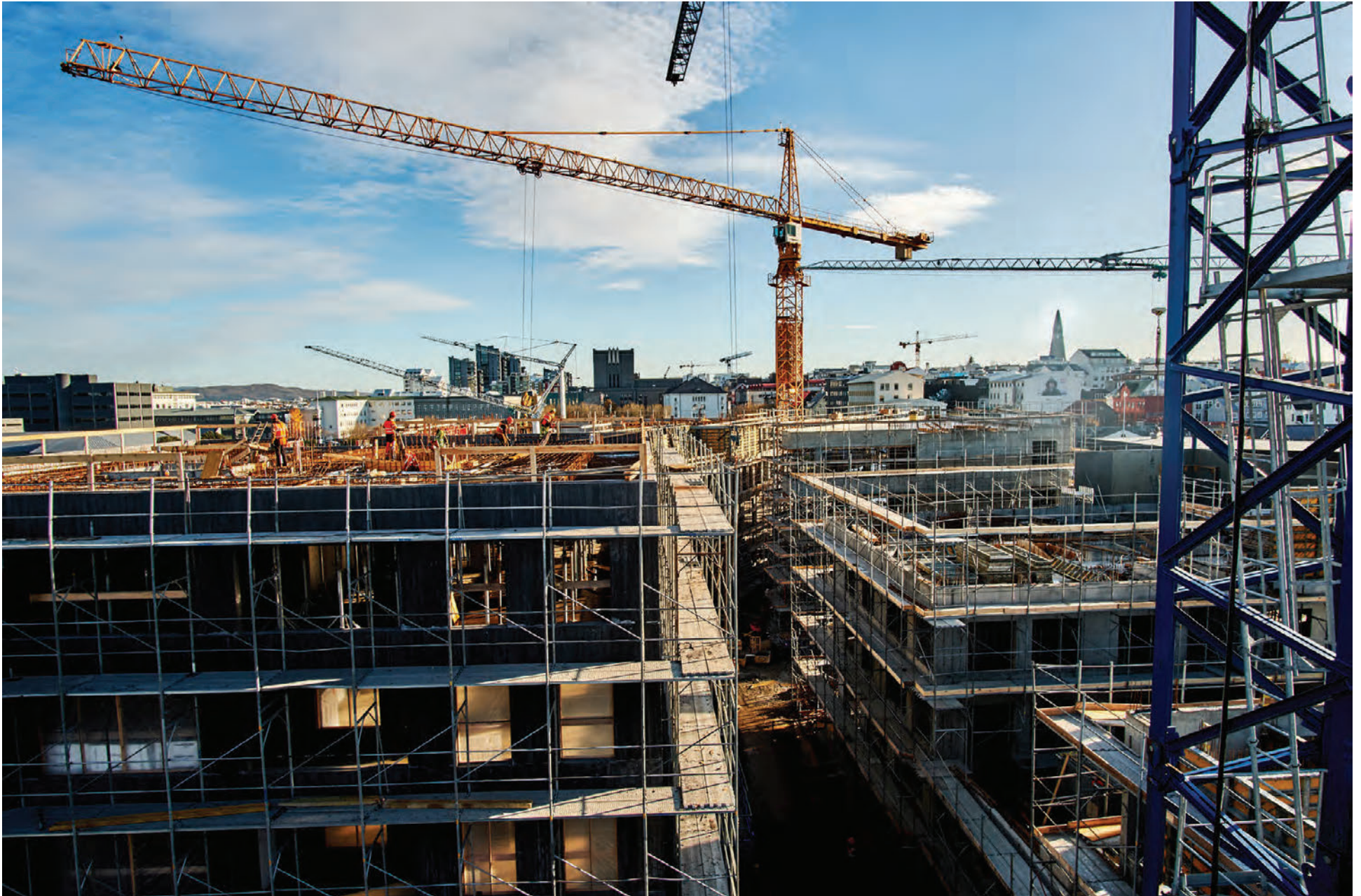
Viða um land eru byggingarkranar ansi algengur gróður en jarðvegur fyrir kranarækt hefur verið frjór undanfarin ár. Sé vel að gáð má sjá átta slíka á myndinni hér fyrir ofan sem tekin var af Hafnartorgi en þar er verið að reisa sjö byggingar, samtals rúmlega 23 þúsund fermetrar að stærð, þar sem verða verslanir, veitingastaðir, íbúðir og skrifstofur. FRÉTTAÞLAÐIÐ/ANTON BRINK
