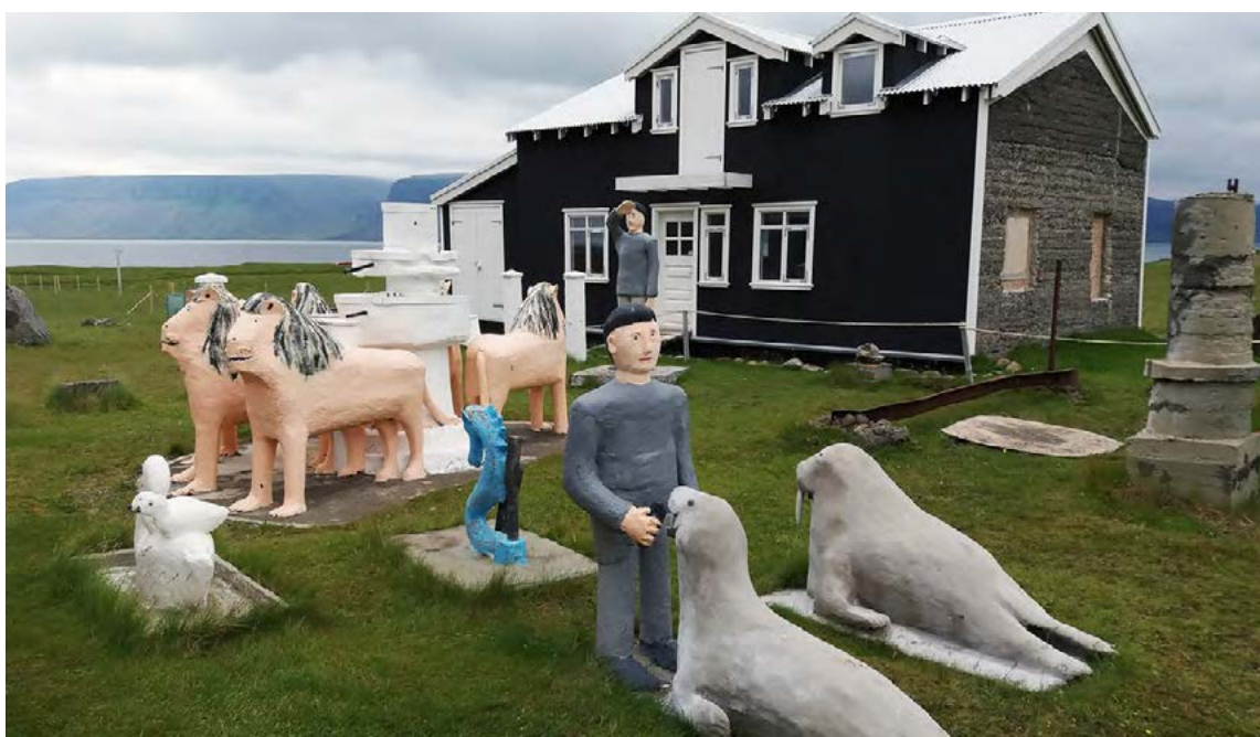
Búið er að endurbæta íbúðarhúsið að utan en fé vantar til innanhússframkvæmda.
