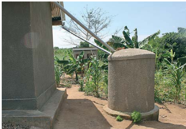
Rennur eru á þökum húsanna og rennur vatn úr þeim í tanka sem reistir eru hlið húsanna. Vatnið í tönkunum dugur fjölskyldunum langt inn í þurrkatímann.
